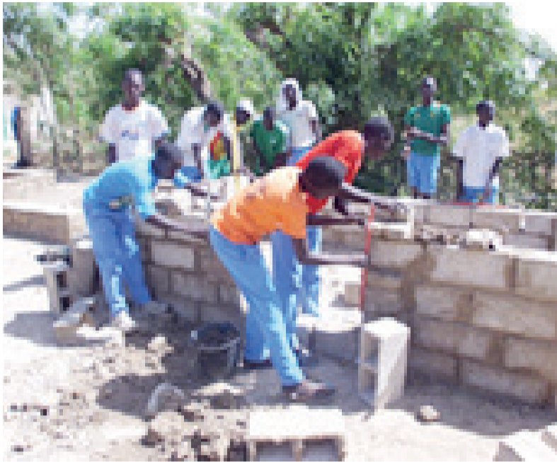
Cours pratique de maçonnerie au Collège Baba Simon
