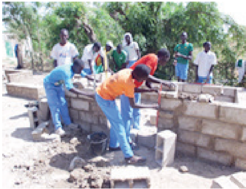
Pratique de la maçonnerie
